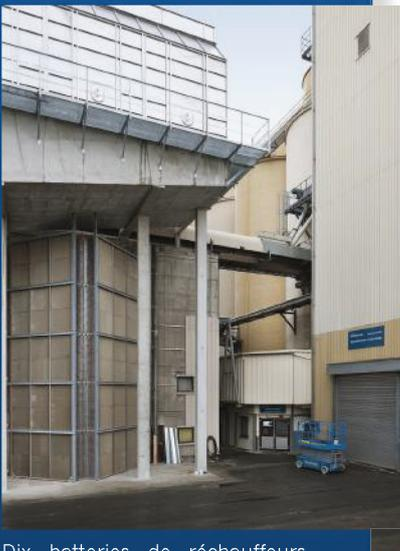
Dix batteries de réchauffeurs d'air Güntner du type GCO (encore sans revêtement sur la photo) produisent de l'air chaud pour la touraille.
