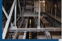
▲ Les neuf refroidisseurs Güntner HIGHSTORE Application installés dans l'entrepôt de surgélation sont placés à une hauteur de 36 m/118 ft au-dessus du bord supérieur des rayonnages sur une plateforme longitudinale.
