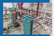
▲ Le rejet thermique de l'évaporateur au NH₃ est transmis à un circuit de glycol par l'intermédiaire d'échangeurs de chaleur à plaques thermowave. Ce rejet thermique sert au chauffage des espaces de bureau et des fondations, pour maintenir durablement le soussol en dessous de l'entrepôt à l'abri du gel et ainsi prévenir tout dommage structurel de la dalle de fondation.
