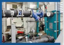
▲ Un évaporateur à plaques thermowave performant au NH<sub>3</sub> refroidit le circuit de glycol pour l'alimentation des refroidisseurs (à l'arrière) et un autre échangeur de chaleur à plaques thermowave (à l'avant) r alimente l'installation centrale de ventilation pour les espaces de bureaux
